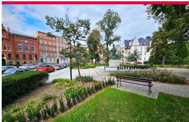
Przebudowa skweru Księcia Bolka
